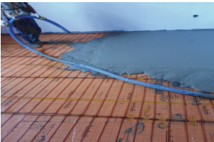
❺ 몰탈작업 몰탈 30mm이하 타설 평활도 유지, 미장 양생건조후 약 3일 난방으로 재건조한다.
