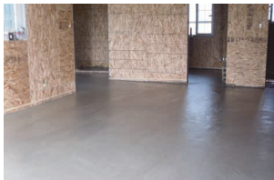
❶ 기초 건물바닥시공 기포 콘크리트 및 스티로폼을 기본 슬라브바닥에 시공을 한다.
