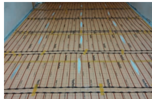
❸ 나노히트 탄소발열체 설치 100mm간격으로 재단 배열하고 벽면에서 100mm 간격을 준다.
