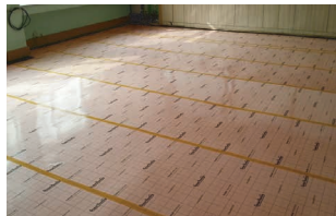
❷ 단열재 설치 두께 5mm의 자사 권장 단열재를 재단하여 설치한다.(선택사항)
