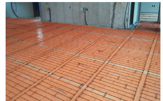
❹ 바닥전용 메쉬 설치 자사 권장 바닥전용 메쉬를 재단 설치한다.
